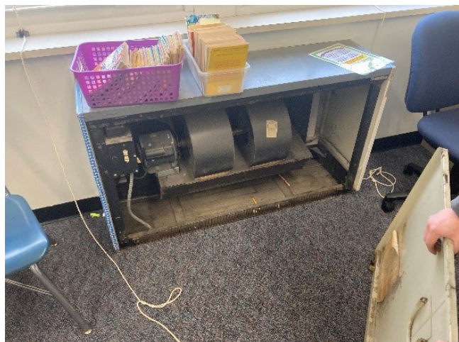
Typ. Exhaust unit ventilator
